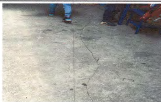
Foto 4: PISO: Sustitución de piso de torta de concreto por piso de ceramico, MÓDULO 1, AULA No.2
