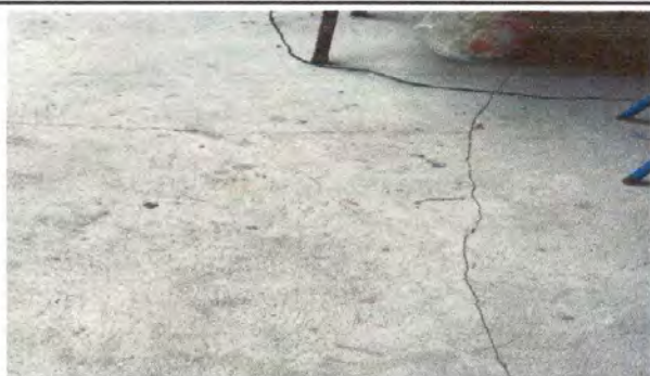
Foto 3: PISO: Sustitución de piso de torta de concreto por piso de ceramico, MÓDULO 1, AULA No.1
