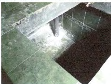
Foto 9: PILA: Sustitución de pila de cemento de dos lavaderos, MÓDULO 2
