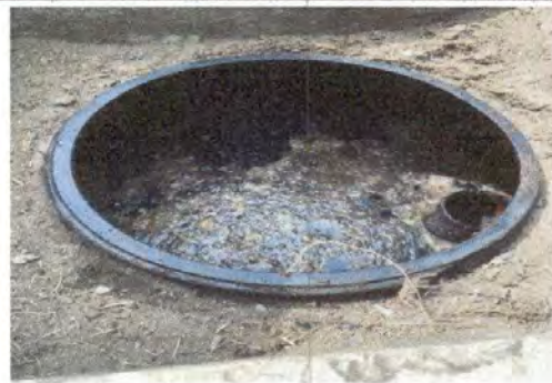
Foto 10: limpieza de fosa séptica MODULO 2
