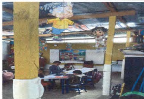
Foto 2: ESTRUCTURA DE TECHO: Sustitución de soporte de madera, por metal, MÓDULO 1
