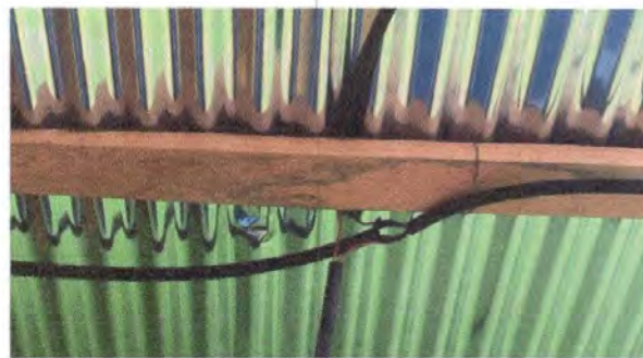
Foto 8: REPARACIÓN DE SISTEMA ELÉCTRICO: Sustitución de cableado eléctrico, Sustitución de ducto eléctrico + accesorios MÓDULO 1
