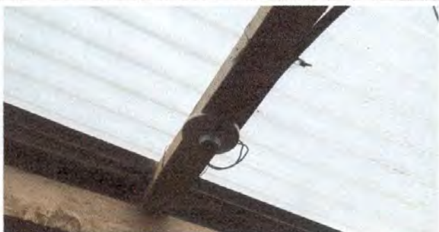
Foto 7: REPARACIÓN DE SISTEMA ELÉCTRICO: Sustitución de focos ahorradores, Sustitución de plafoneras, MÓDULO 1
