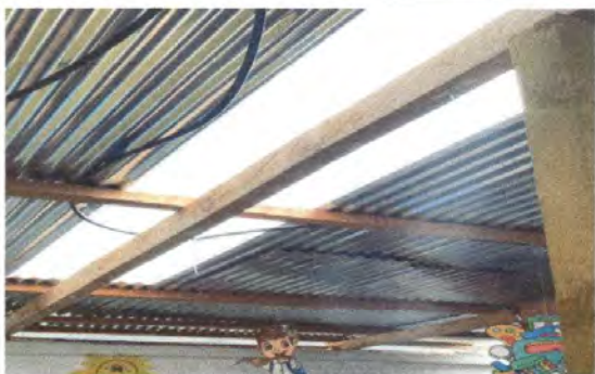
Foto 1: CUBIERTA DE LÁMINA: sustitución de lámina por lámina troquelada aluzinc calibre 26 y sustitución de elementos de fijación, MÓDULO 1
